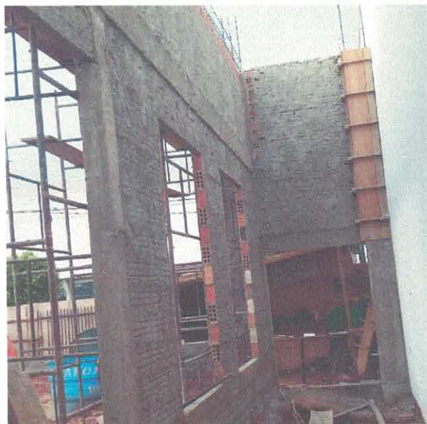
Concretagem de pilares, vigas, grauteamento de vergas e contravergas.
