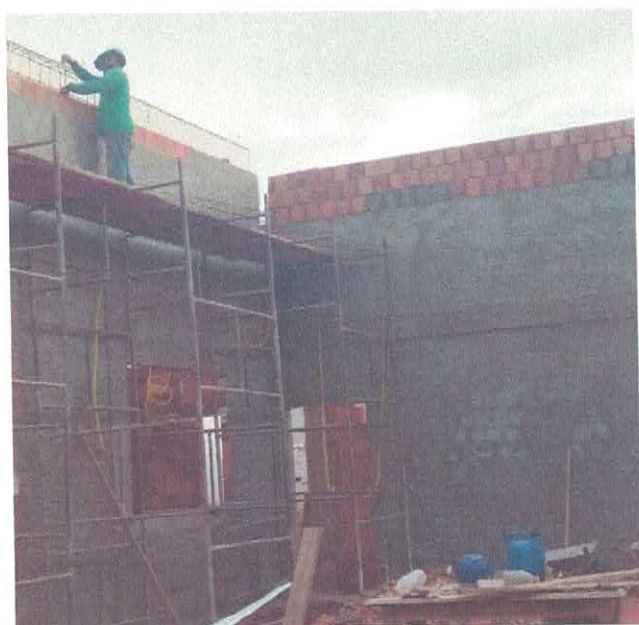
Montagem desmontagem de forma, armação de pilares, vigas, alvenaria de blocos cerâmicos 9x19x19, Chapisco.
