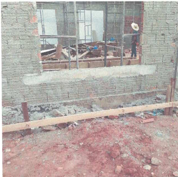
Concretagem de pilares, vigas, grauteamento de vergas e contravergas.
