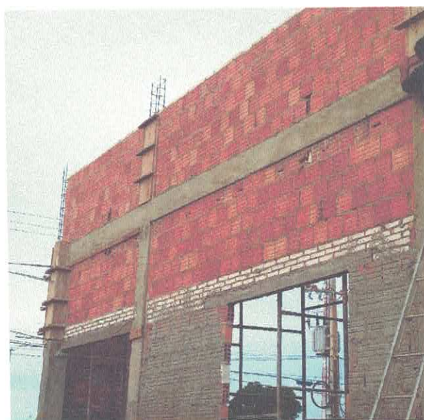
Montagem desmontagem de forma, armação de pilares, vigas, alvenaria de blocos cerâmicos 9x19x19, Chapisco.
