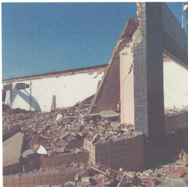
Remoção pilares, vigas, lajes, janelas
