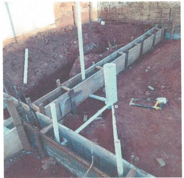
Instalações sanitárias, dutos, joelhos, caixa sinfonada.
