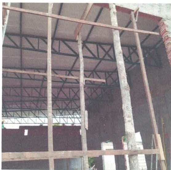
Telhamento Telha metálica termoacústica 30mm.
