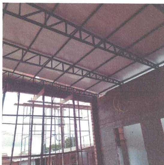
Tesouras inteiras em aço de 11m e trama em aço composta por terças em aço.
