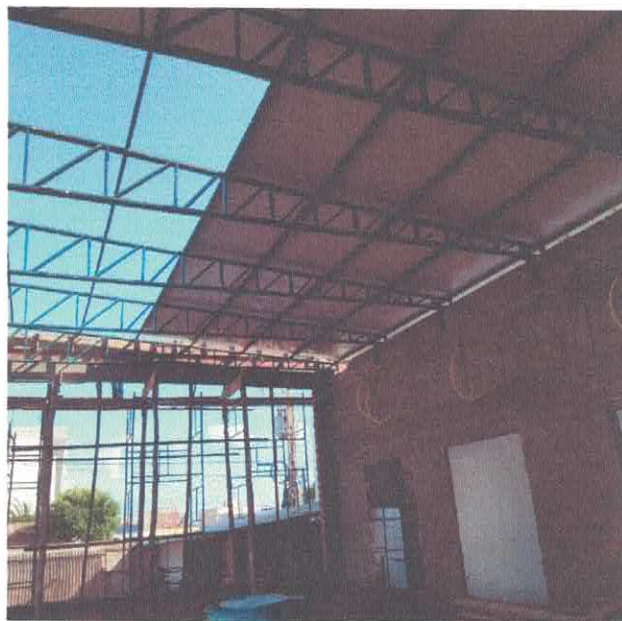
Tesouras inteiras em aço de 11m e trama em aço composta por terças em aço.
