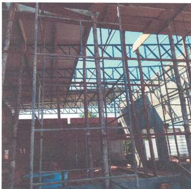
Tesouras inteiras em aço de 11m e trama em aço composta por terças em aço.
