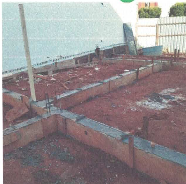
Concretagem da vigas baldrame e tubos drenagem.
