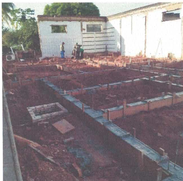
Concretagem da vigas baldrame e tubos drenagem.
