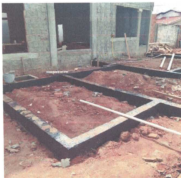
Impermeabilização da estrutura.
