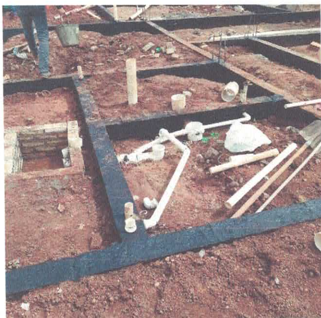
Tubos e conexões de esgoto.
