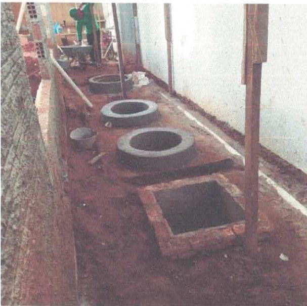
Fossa séptica e caixas de esgoto, aterro.
